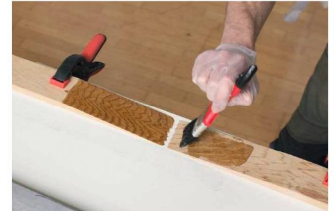
4 - Auftragen von Epoxidharz auf die Klebeflächen
