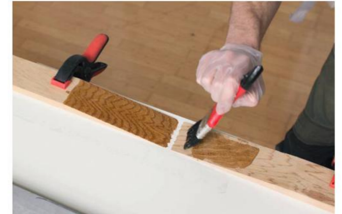
4 - Auftragen von Epoxidharz auf die Klebeflächen
